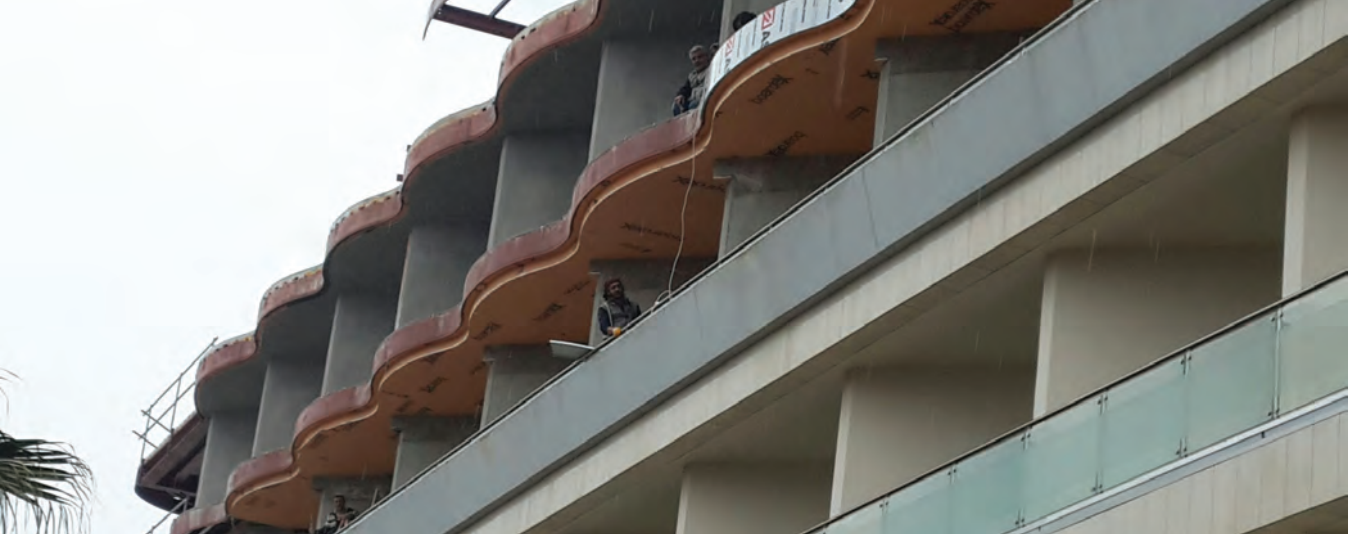
Boardex saçak altı uygulaması
