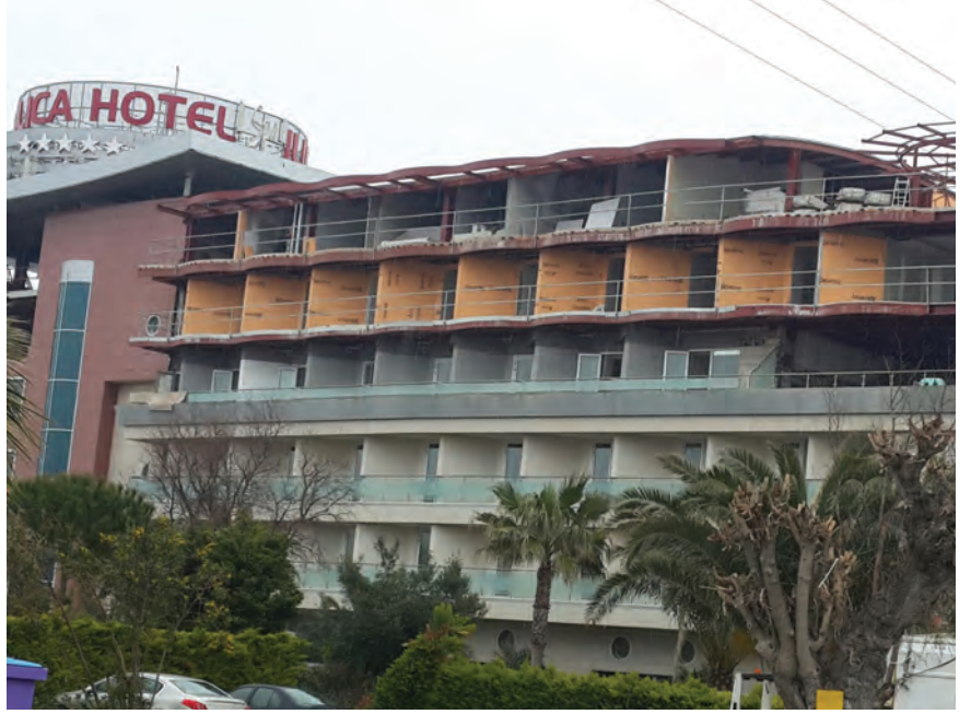
BoardeX ayırıcı duvar uygulaması
