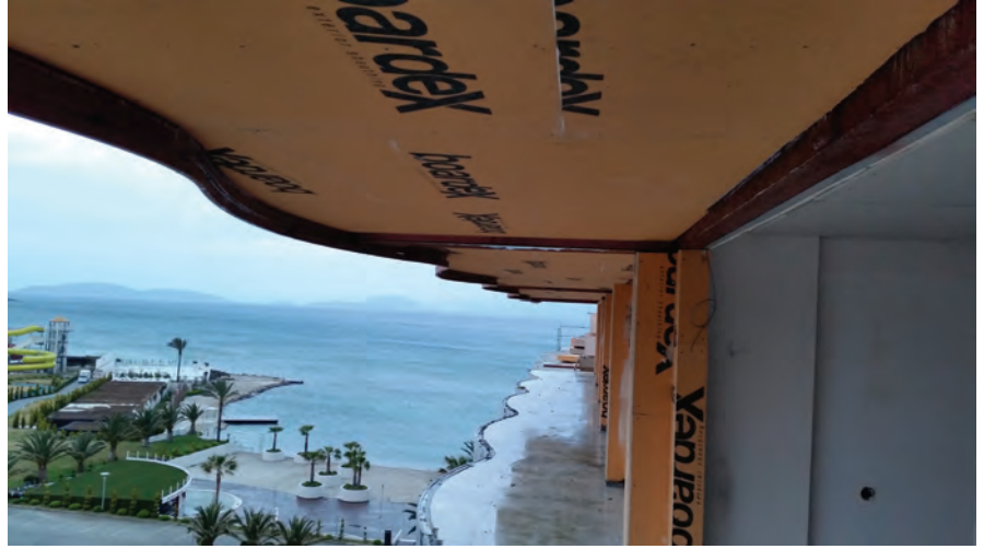
BoardeX saçak altı uygulaması
