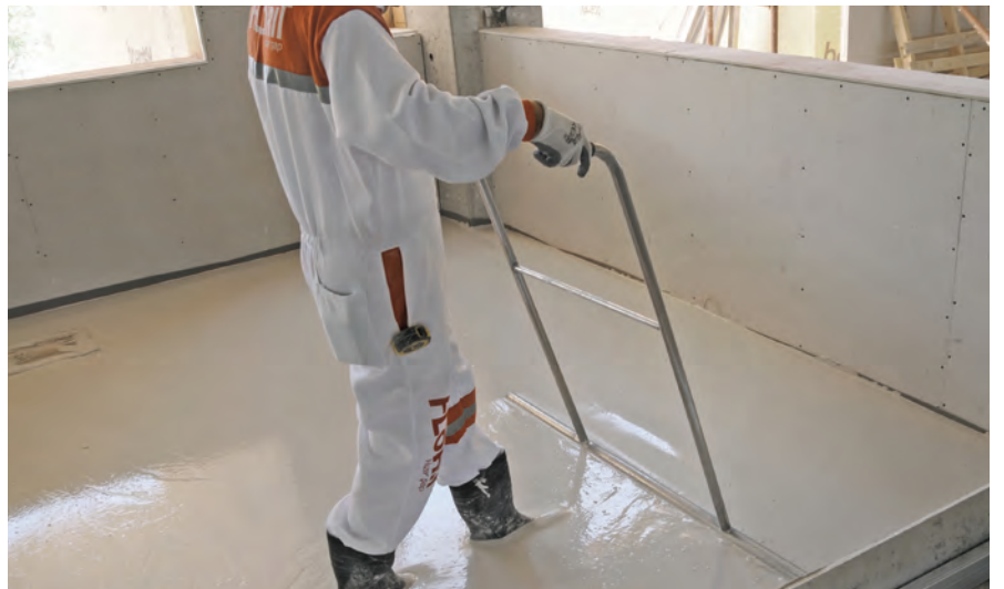
MAXICOAT yüzeyinin tapalanması
