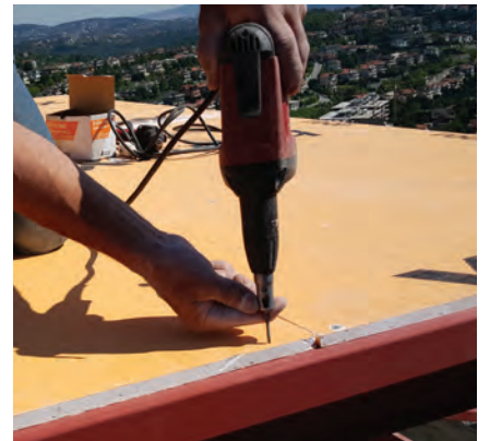
BoardeX roof çatı uygulaması
