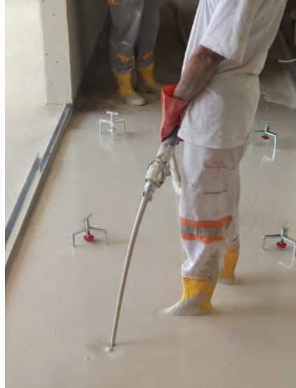
Zeminin MAXICOAT doldurulması
