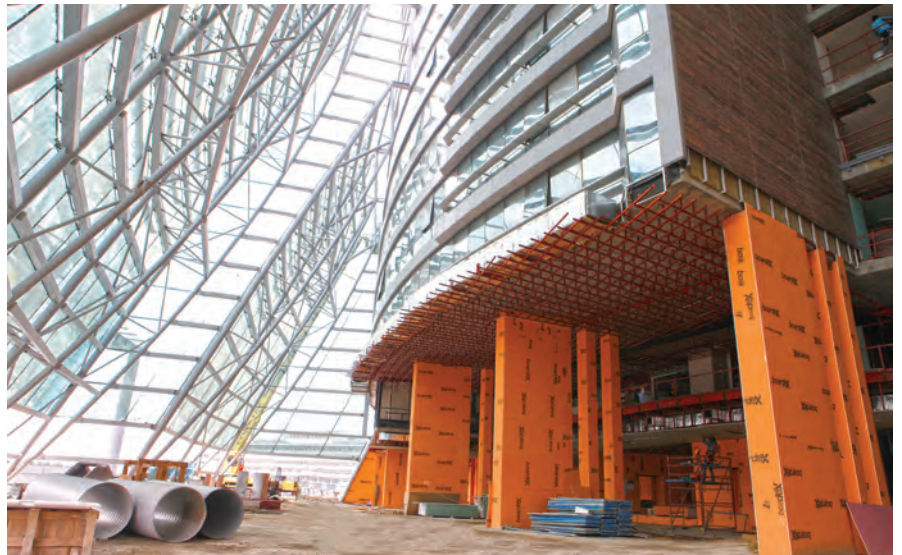
Boardex giydirme uygulaması
