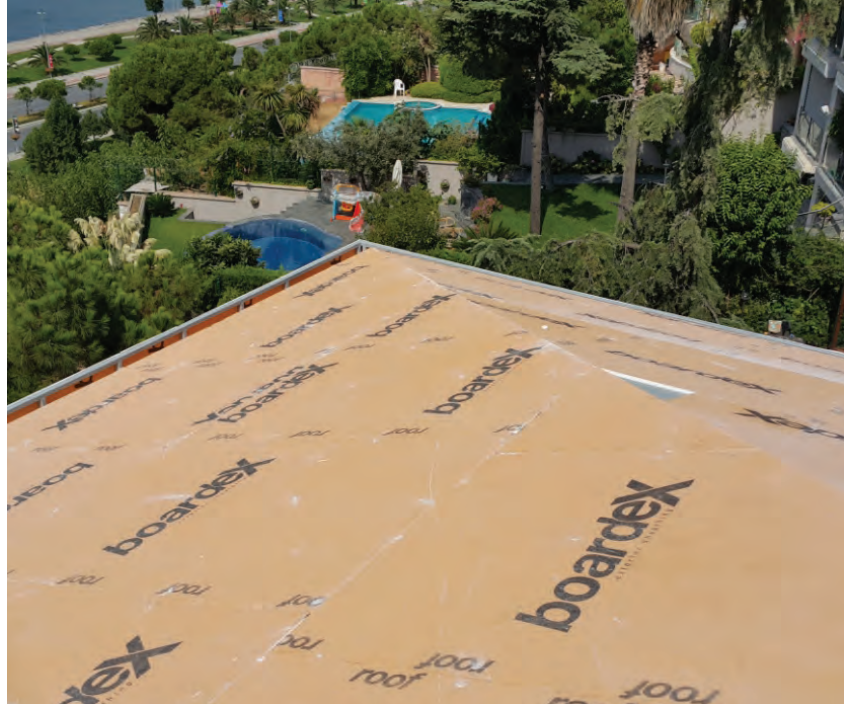
BoardeX roof çatı uygulaması
