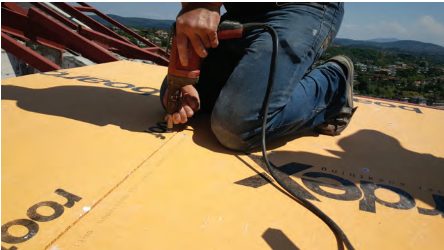
BoardeX roof çatı uygulaması
