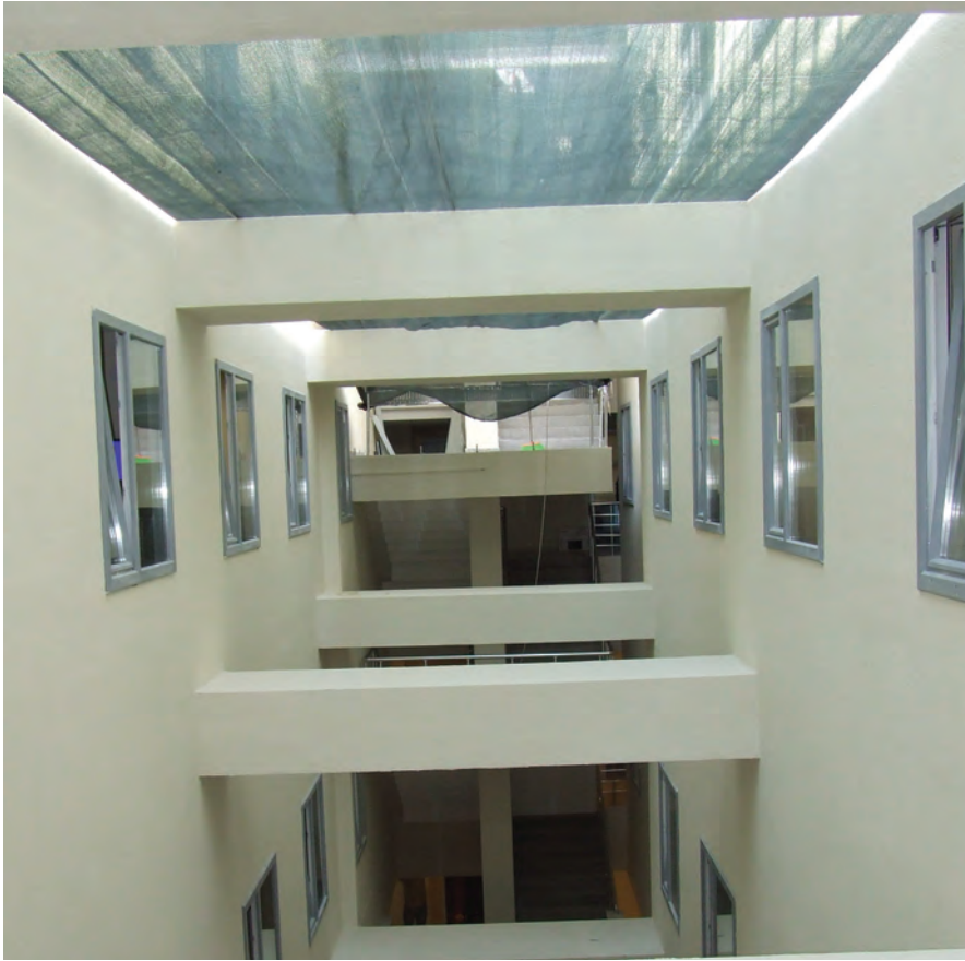
COREX bölme duvar uygulaması
